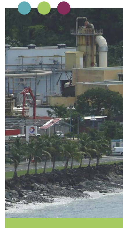
Centrale géothermique de Bouillante, un exemple du développement des énergies renouvelables
