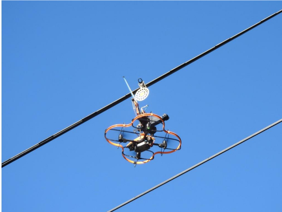
Figure 2 : Pose de balise Birdmark par drone, sur le domaine skiable des Arcs/Peisey-Vallandry. © S. Berthillot (PNV)
