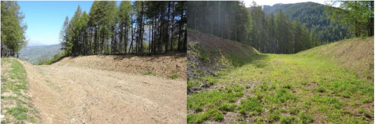
Figure 3 : Piste de Vernie Rouge avant travaux (à gauche) et deux ans après les travaux (à droite). © CBNA
